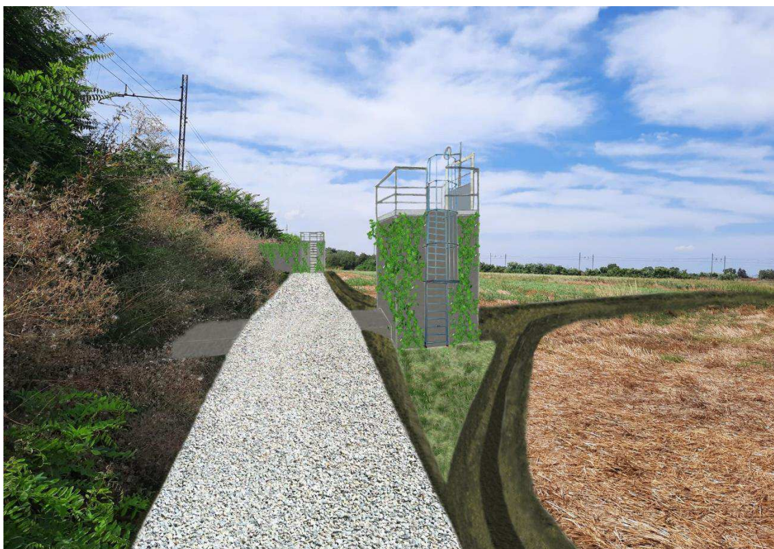
Figura 5: Area Fornice 3 e Fornice 4 – Situazione post operam - fotoinserimento scatolari e pozzetti in c.a. con paratoia, strada bianca di accesso e nuovi fossati in progetto
